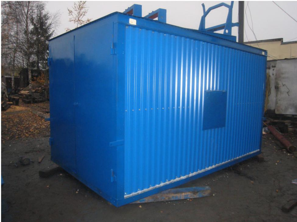
Контейнер утеплённый тип "Север" предназначен для размещения электроагрегата дизельного мощностью 60-75кВт.
