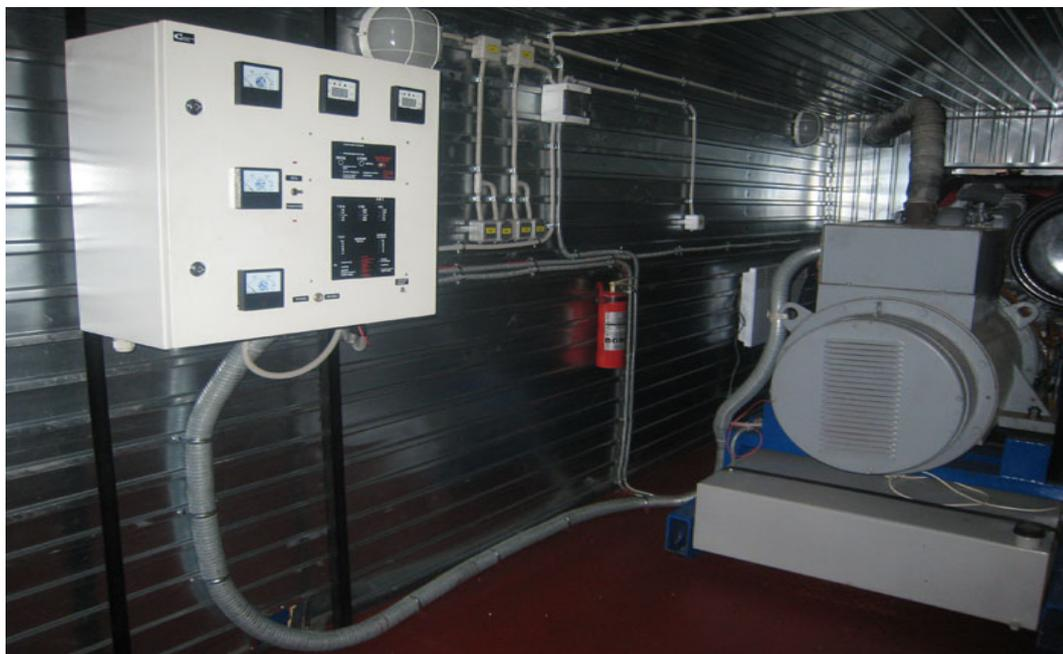
Контейнер утеплённый тип "Север" предназначен для размещения электроагрегата дизельного мощностью 150-160 кВт.
